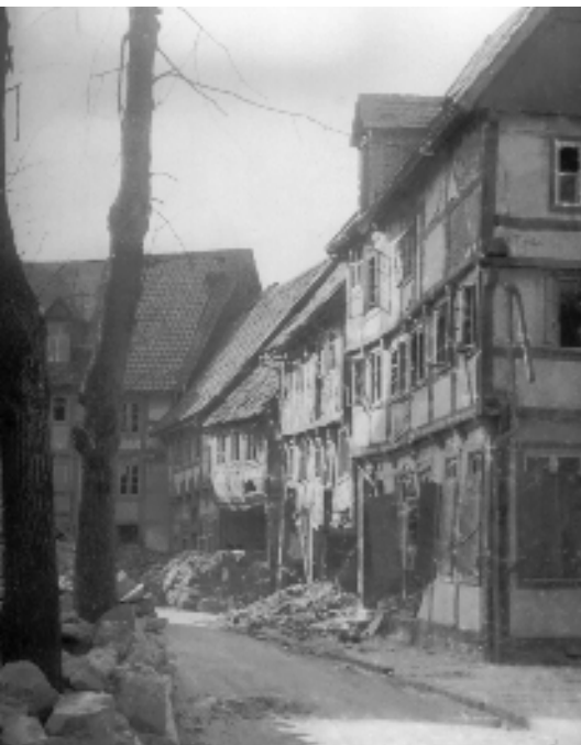
Am Alten Kirchplatz nach den Bombenangriffen, 1945
